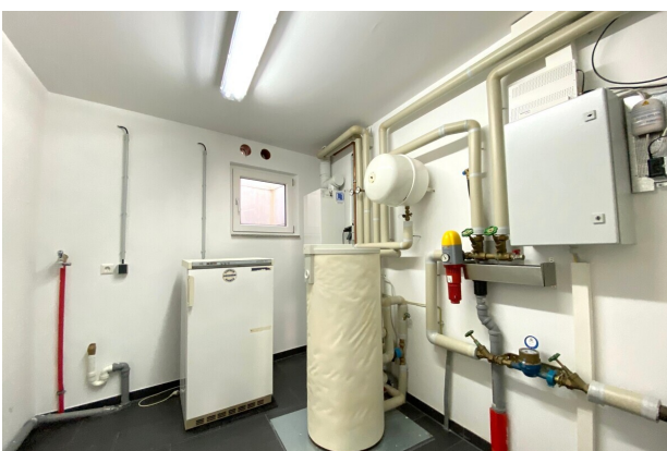
Wasch und Heizraum UG
